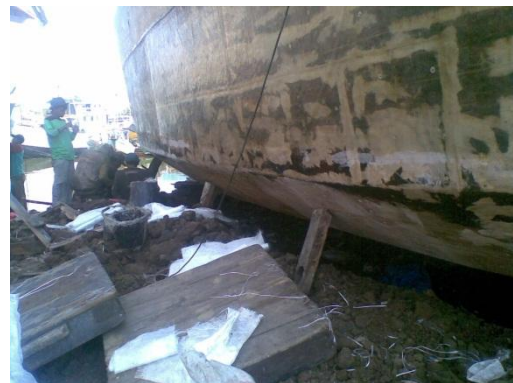
Gambar.6 Repair perahu dengan resin
