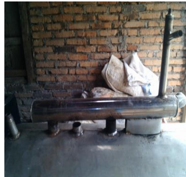
Gambar 17. Pemanas Atas Boiler
