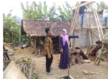
Gambar 11. Pembangunan Rumah Pelindung Instalasi Alat Finishing
