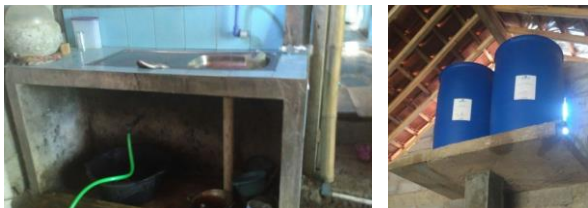
Gambar 9. Instalasi Air untuk Proses Finishing
