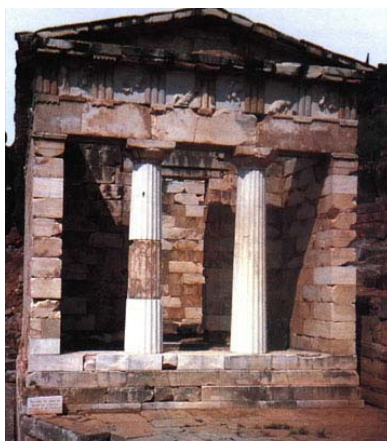
Gambar 1 Athenian Treasury, Delphi, Yunani 490 SM (Bangunan kecil yang sangat indah di salah satu sudut kota. Struktur bangunan ini adalah yang pertama yang dibangun dari marmer seluruhnya.) Sumber: Encyclopaedia Britannica (1987)
