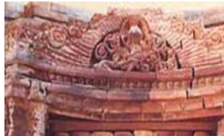
Gambar 11 Teknik Susun Batu Bata dengan menggunakan campuran air, kapur, dan gula
