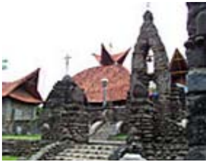
Gambar 13 Tangga pada area pintu gerbang
