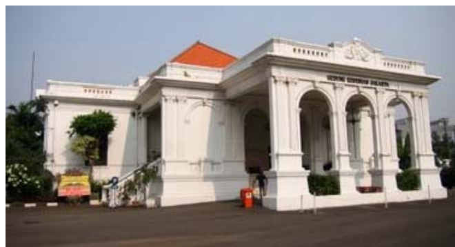
Gambar 7 Gedung Kesenian Jakarta tahun 2009
