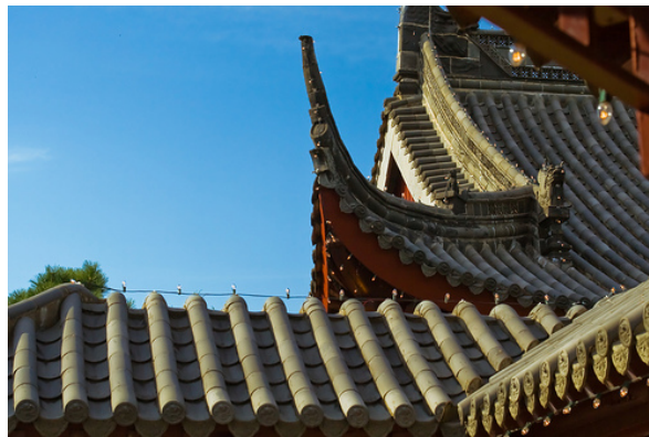
Gambar 5 Ujung Atap yang Mencuat seperti Ekor Burung Walet di Cina Daratan (Knapp, 2010:262)
