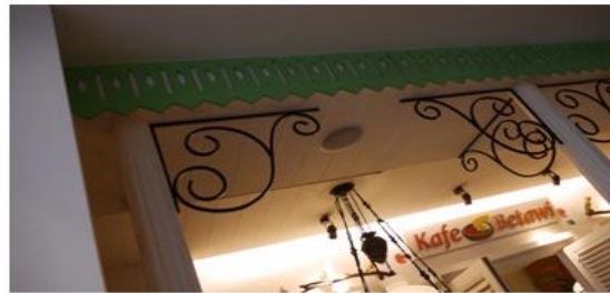
Gambar 19 Lisplang Gigi Balang dan Penyangga Plafon (Sumber: foto pribadi, 2014)
