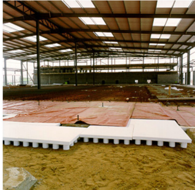
Gambar 6. Aplikasi geofoam sebagai sarana drainasi dan ventilasi di bawah pelat lantai.
