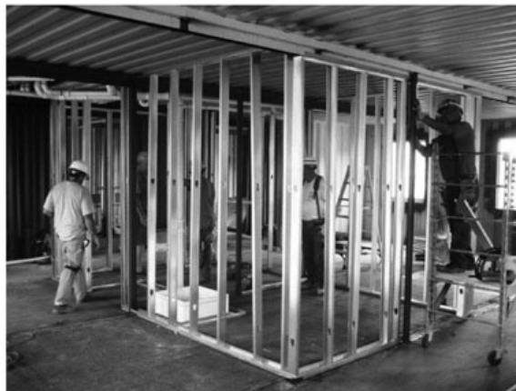
Gambar 2. Interior kontainer kapal yang dirancang ulang dan ditambahkan strukturnya untuk memenuhi kebutuhan rumah tinggal (sumber: Hart, 2011).
