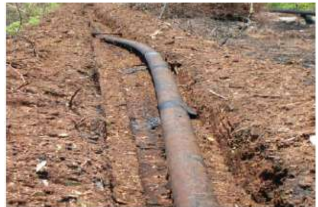
Gambar 1. Upheaval Buckling pada pipa penyalur gas akibat kenaikan temperatur [2]
