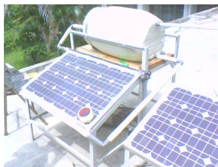
Gambar 4. Alat Konversi Energi Surya Menjadi Listrik dan Air Panas
