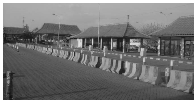
Gambar 3. Kondisi eksisting area berjualan di Pelabuhan Kamal
