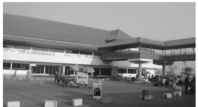
Gambar 2. Kondisi eksisting terminal Pelabuhan Kamal
