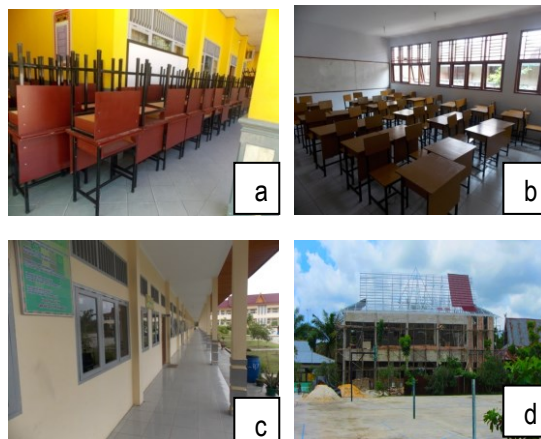
Gambar 2. Komponen bangunan sekolah ; a.Meja yang kakinya dari besi. b. kursi yang kakinya dari besi c tiang bangunan dari beton d Atap dengan rangka baja ringan
