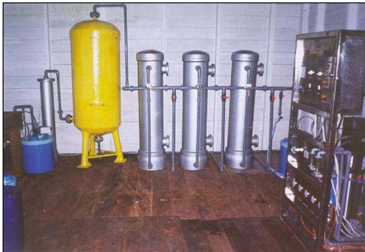
**Gambar 6. Peralatan Unit RO, Filter dan Reaktor Tank**
