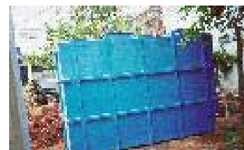
Teknologi Pengolahan Limbah Aplikasi Biofilter untuk Industri Pencucian Tekstil. Rancang bangun dan pilot plan alat pengolah limbah dengan proses biofilter kapasitas 20m 3 /hari
