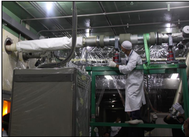
Gambar 5. Posisi manipulator lurus ke lubang di dinding hotcell
