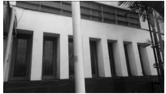
Gambar 4. Jendela Bangunan Eksisting Stasiun
