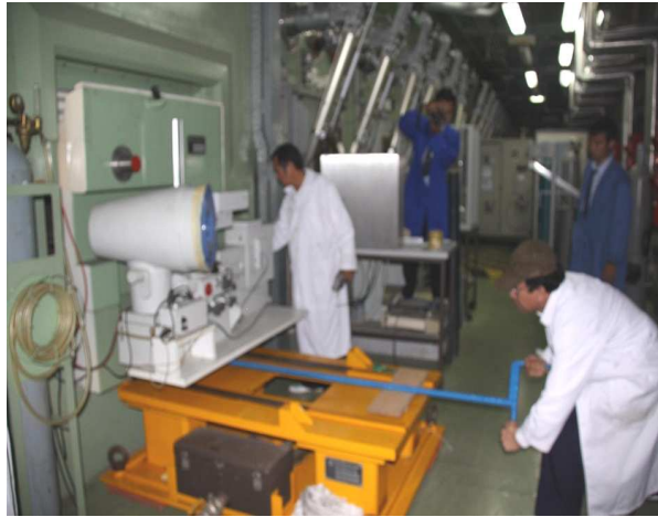
Gambar-3. Pengukuran paparan radiasi \gamma di depan pintu hotcell 107.
