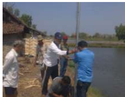
Gambar 3: Pemasangan Sudu(blade) dan Generator pada Tiang Kincir Angin
