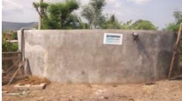
Pembuatan bak penampungan air sumur pompa selesai 100%
