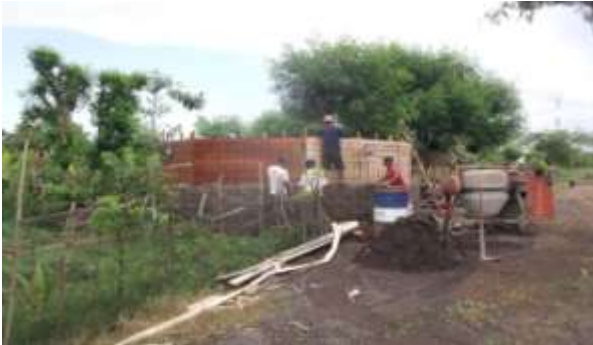
Pembuatan bak penampungan air sumur pompa selesai ±40%
