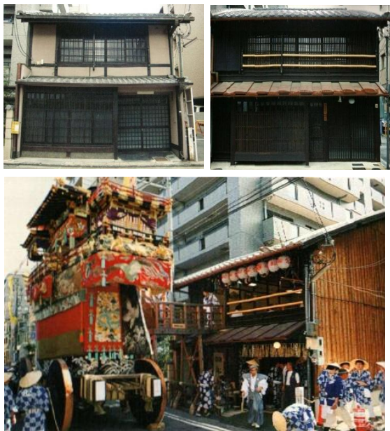
Gambar 5. Pemanfaatan bangunan tradisional sebagai posko yamahoko Kiri atas: bangunan sebelum direnovasi, kanan atas: bangunan setelah direnovasi, bawah: suasana saat festival digelar (Sumber: Kyoto Center for Community Collaboration , 2009)
