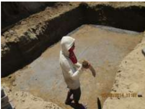
Gambar 6. Pekerjaan Lantai Kerja
