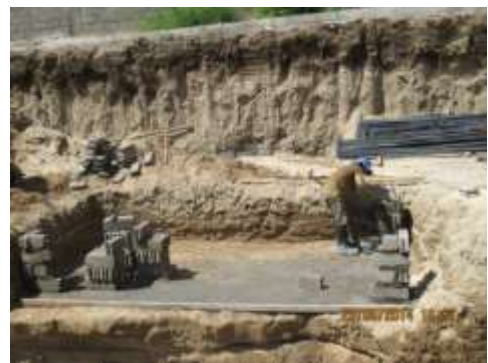
Gambar 8. Pekerjaan bekisting batako
