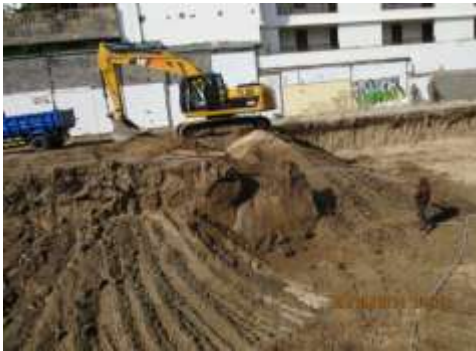
Gambar 5. Proses penggalian menggunakan excavator
