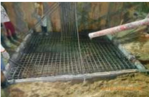
Gambar 10. Pengecoran Plat Poer
