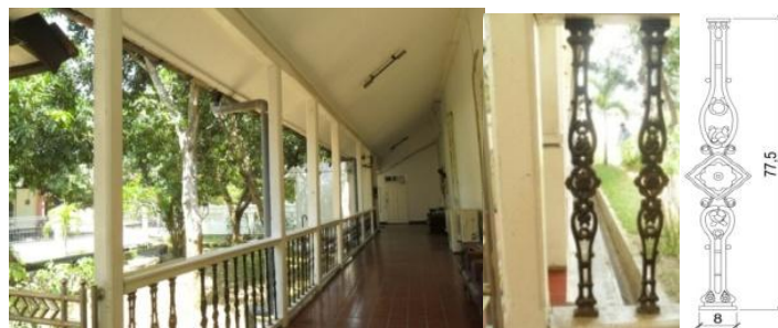
Gambar 7. Jenis balustrade pada bangunan rumah dinas Bakorwil Sumber: Dokumentasi Pribadi, 2014
