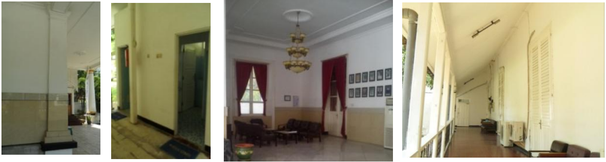
Gambar 6. Kondisi dinding eksterior bangunan rumah dinas Bakorwil Sumber: Dokumentasi Pribadi, 2014
