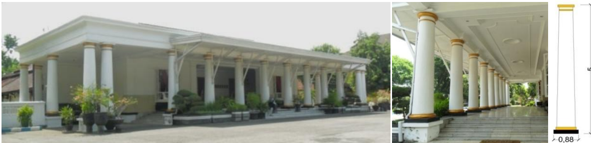
Gambar 9. Kolom Tuscan yang menjadi salah satu ciri bangunan Indische Empire Style Sumber: Dokumentasi Pribadi, 2014
