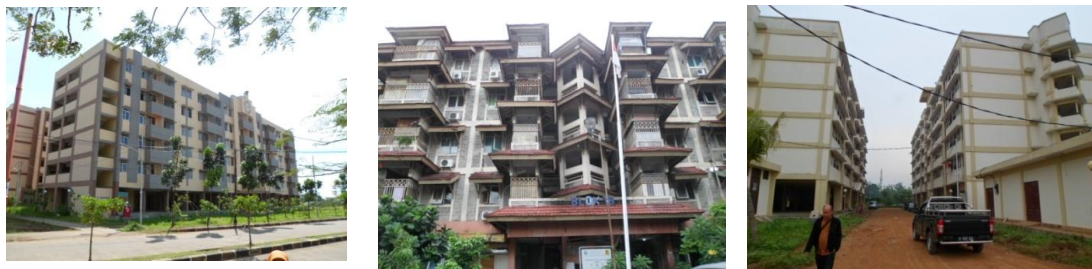
Gambar 1. Rumah Susun Marunda, Cipinang Besar Selatan dan Tebet (Sumber : Dokumentasi Pribadi, 2014)
