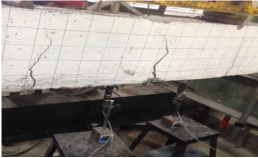
Gambar 7. Pola keruntuhan balok beton bertulang bambu 2D12
