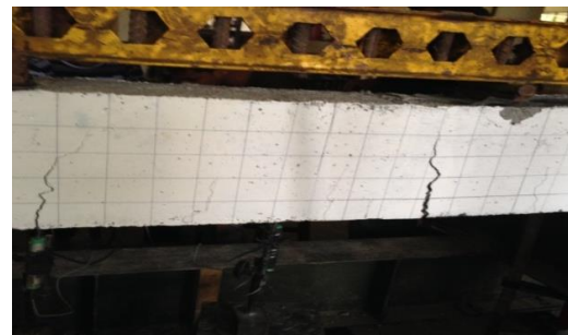
Gambar 6. Pola keruntuhan balok beton bertulang baja
