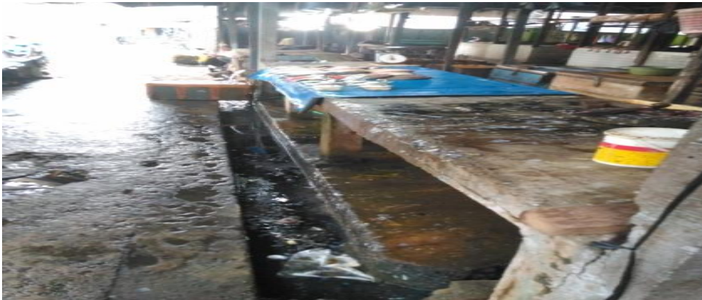
Gambar 3. Kondisi Umum Pasar Tua
