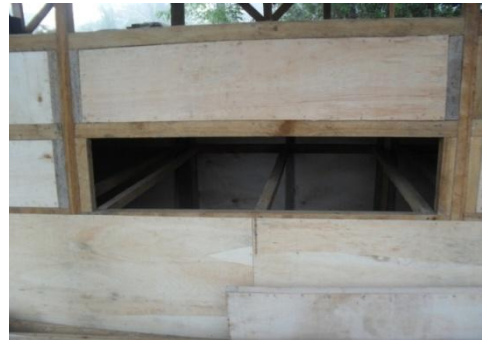
Gambar 5. Konstruksi dalam ruang pengering dan rak pengeringan
