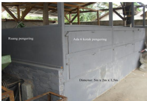
Gambar 3. Konstruksi ruangan pengeringan dengan kapasitas 400 kg
