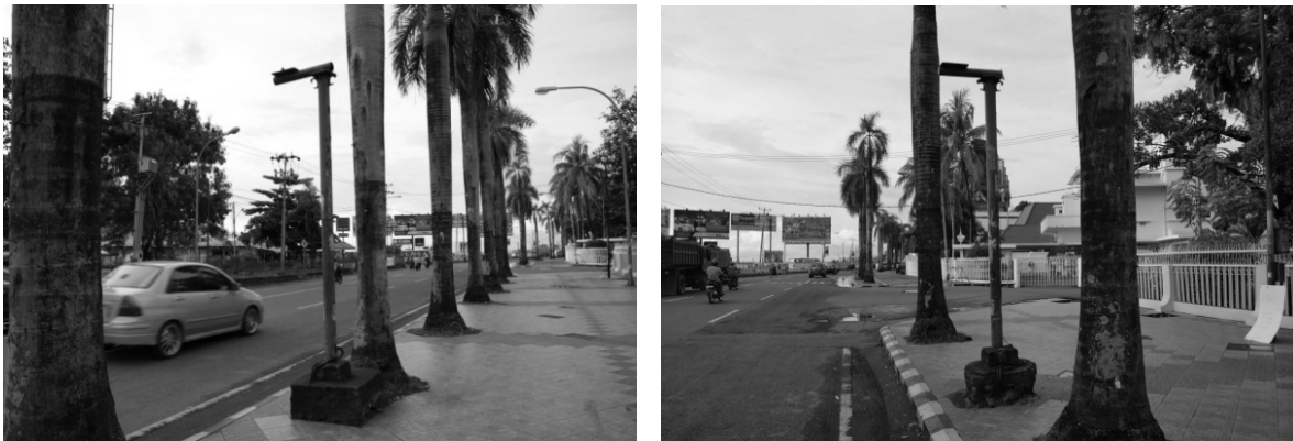
Gambar 4 Lampu Penerangan Pejalan Kaki dengan Kondisi Rusak
