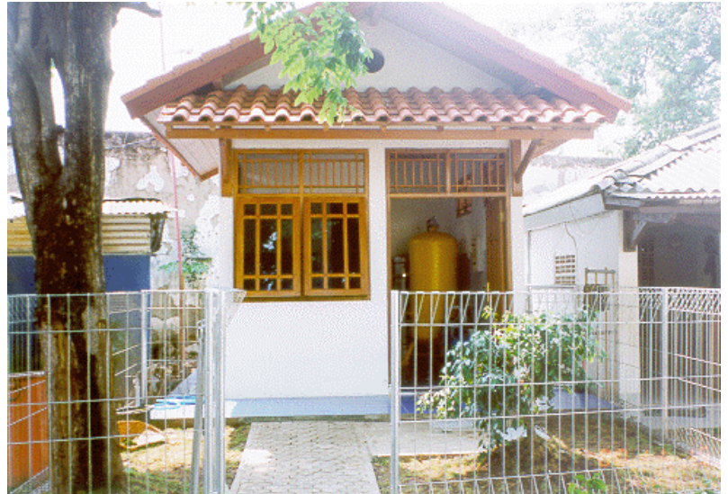
Gambar-14 Bangunan Pelindung pengolahan air sadah menjadi air siap minum
