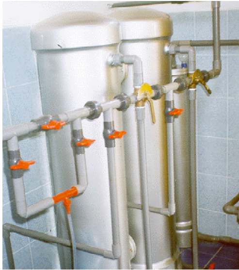
Gambar-9 Filter Multi Media, Mangane Zeolite, Ion Exchange untuk mengolah air sadah
