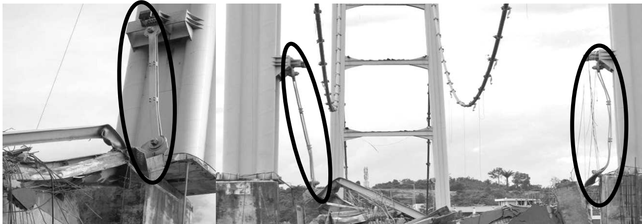
Gambar 5. Tower strap sebagai pengikat rangka jembatan langsung pada pilon baja
