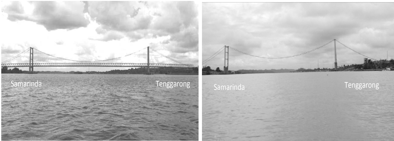
Gambar 4. From something to nothing : Jembatan (Gantung) Kartanegara sebelum keruntuhan (kiri), dan setelah keruntuhan (kanan), tanpa rangka jembatan dan lantai kendaraan
