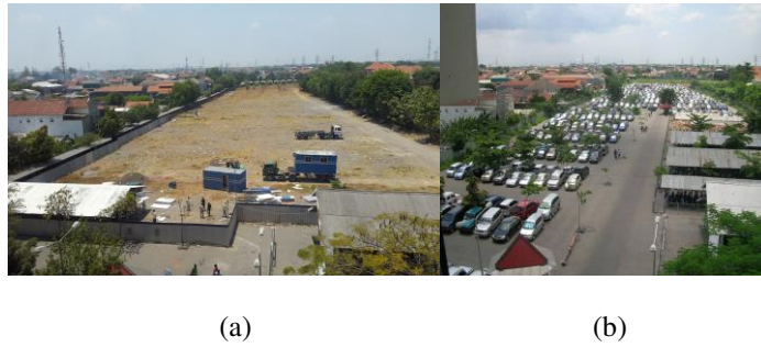
Gambar 1 Pembangunan Gedung P1 dan P2 dan Parkir Mobil pada Lahan Kampus Timur
