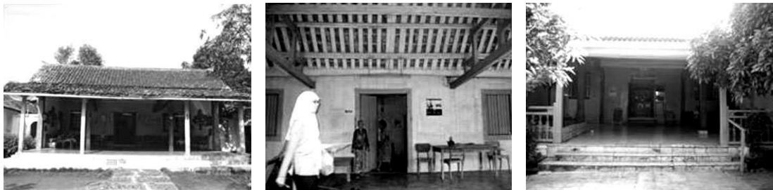
Gb.6. Tampak depan rumah Cina dari kayu (rumah geladak)
