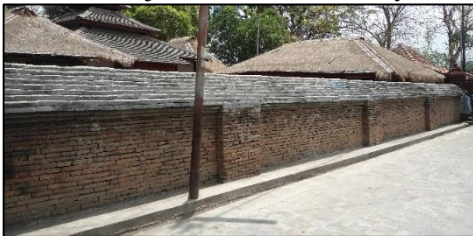
Gambar 4. Tembok keliling Kompleks Situs (Sumber: Mujabuddawat, 2013)
