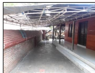
Gambar 13. Pintu masuk sisi utara ruang Serambi Masjid (Sumber: Mujabuddawat, 2016)
