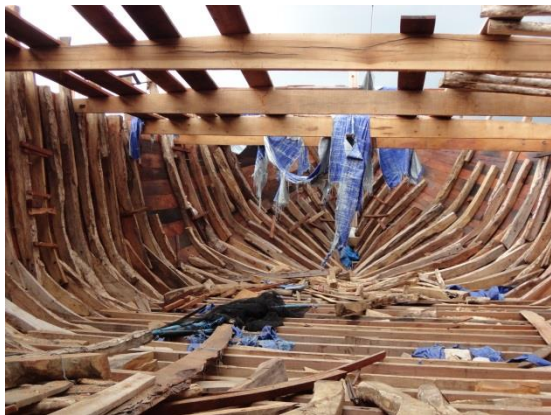
Gambar 1. Konstruksi kapal kayu yang dibuat pada galangan kapal kayu.
