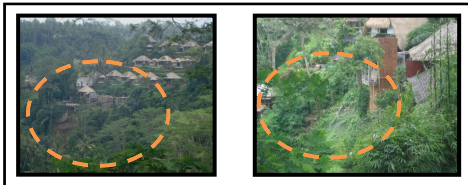
Gambar 12 Longsor pada Tebing yang Dibangun Akomodasi Wisata Sumber : Hasil Pengamatan, 2012
