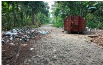
Gambar 1. Kondisi Eksisting TPS RW 1 Sumber : Dokumentasi Penulis, 2016
