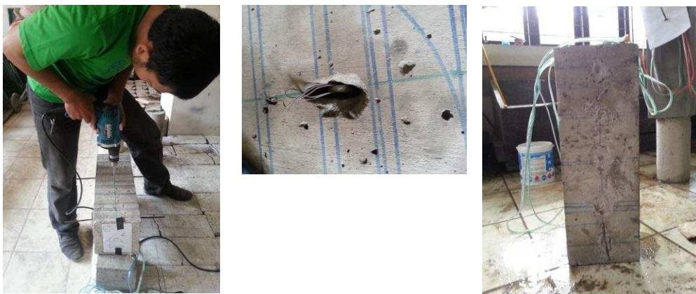
Gambar 4. Proses pemasangan pen-binder
