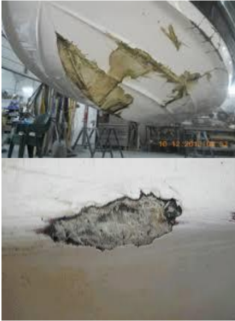
Gambar 16. Visual kerusakan/keretakan pelat zona lambung
