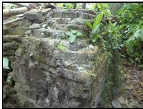
Gambar 11: Kondisi Detail Lumut yang Terdapat pada Struktur Bata di Situs Pleret (Dokumentasi Tim, 2015)
