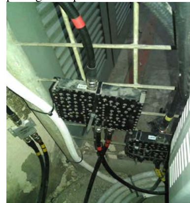
Gambar 13 Penggantian Triplexer
