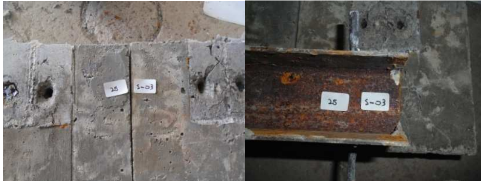
Gambar 11. Kegagalan spesimen 20 S- 03
