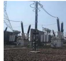
Gambar 4 Bentuk Fisik Arrester type HLMN.
