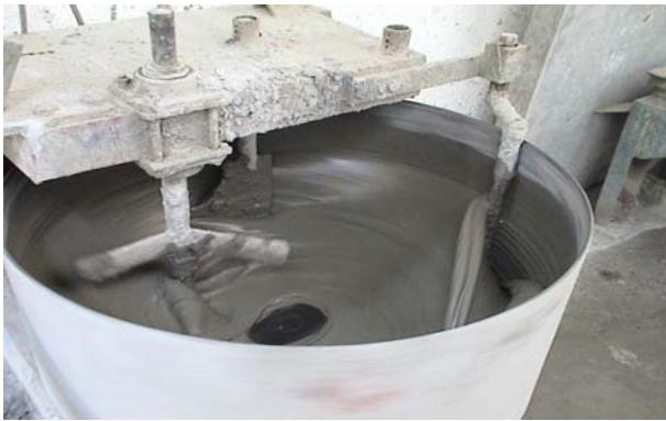
Gambar 7. Tahap pertama: persiapan mortar
