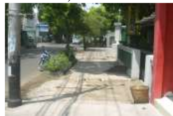
Gambar 4.30 Saluran tertutup beton untuk jalur pedestrian alternatif
