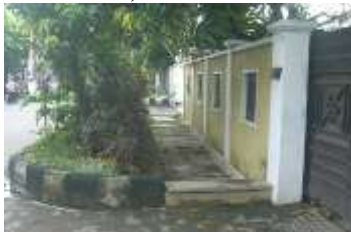
Gambar 4.26 Saluran ditutup beton untuk alternative jalur pedestrian sempit
