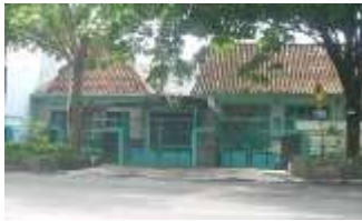
Gambar 4.12a Tampak depan rumah tinggal dan tempat usaha UD. Subur
