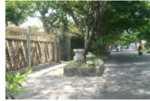
Gambar 4.27 Saluran tertutup beton untuk jalur pedestrian alternatif
