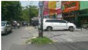
Gambar 4.43 Saluran dan drainase ditutup beton untuk parkir mobil pengunjung
