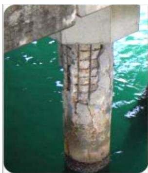
Gambar 1. Kerusakan beton pada struktur di lingkungan agresif
