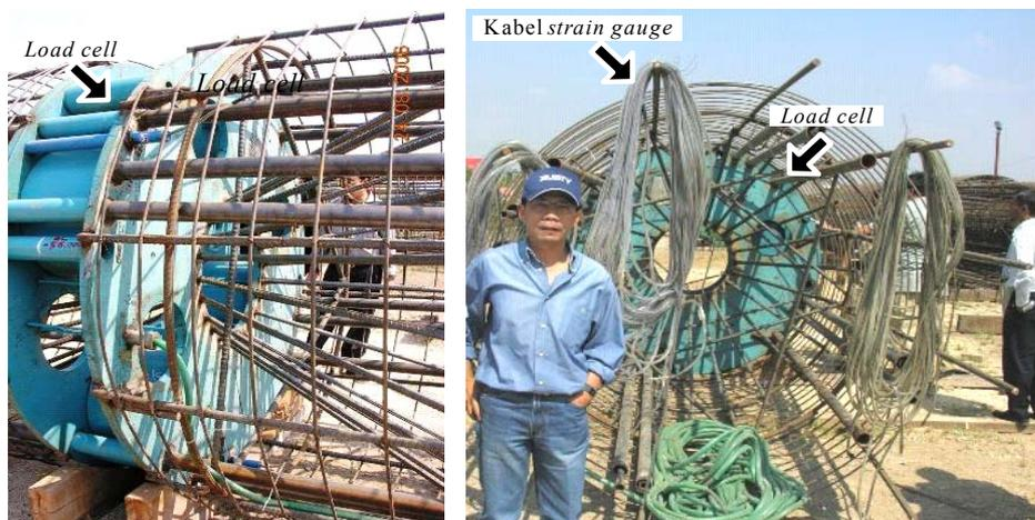
**Gambar 9.** Load cell yang dipasang pada reinforcement cage
