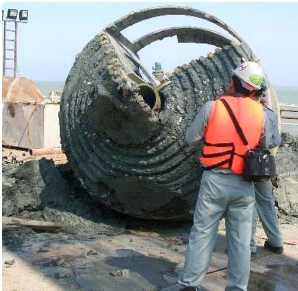
Gambar 3. Material *clay-shale* yang menempel pada mata bor
