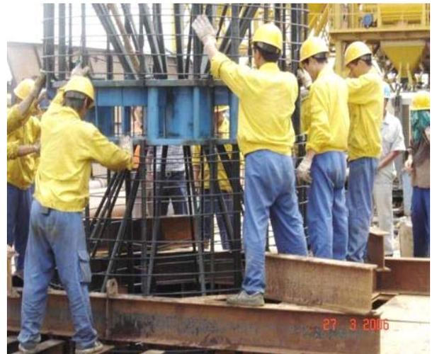
**Gambar 14.** Pemasangan *reinforcement cage* pada jembatan utama
