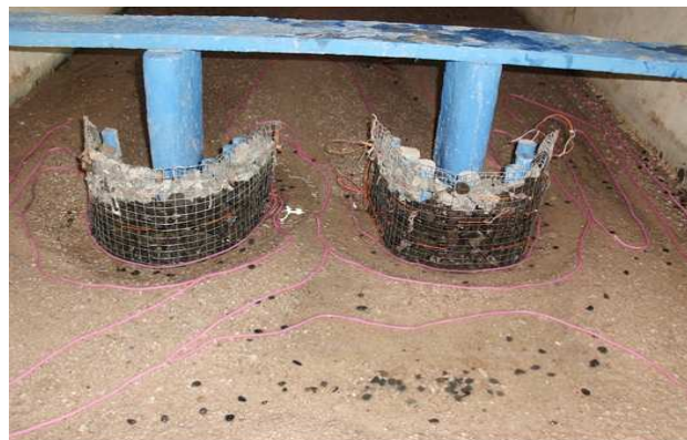
Gambar 6. Pola gerusan yang terjadi pada pilar dengan pengaman bronjong.
