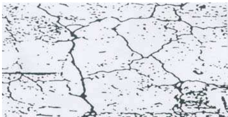
Gambar 1. Retak akibat reaksi alkali-agregat
