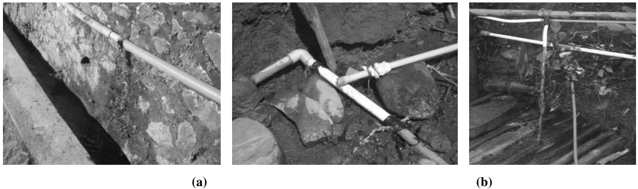
Gambar 4. Kondisi Perpipaan Desa Argosari; a). Perpipaan b).kebocoran pipa (Sumber: Dokumentasi penelitian)
